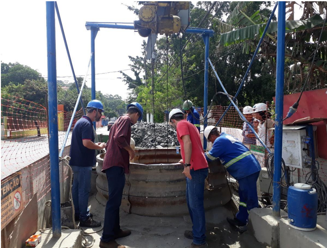
Foto 1 – Poço de Visita instalado em sistema viário.
